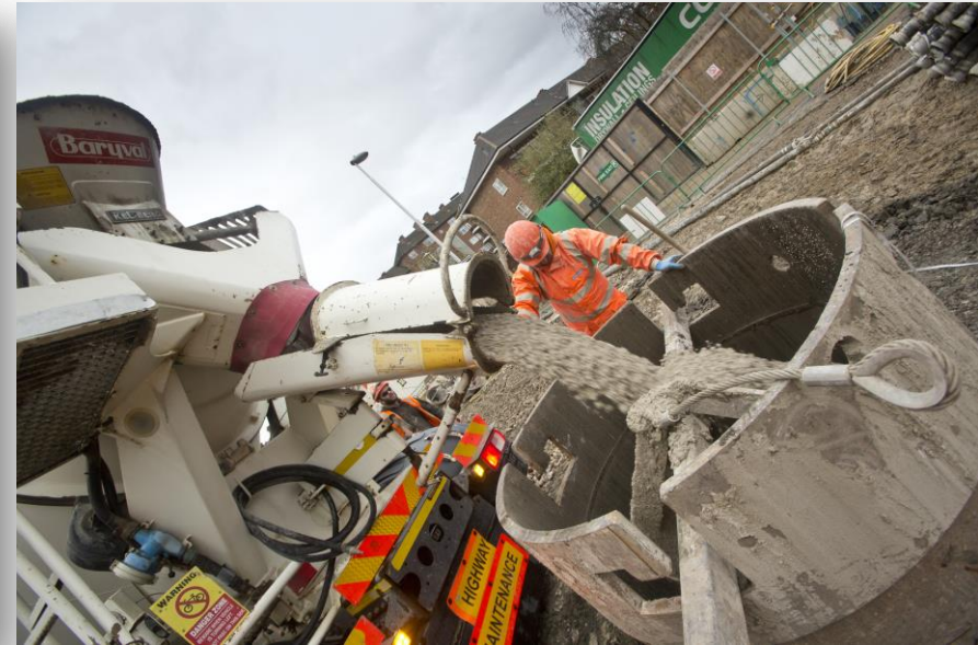
Concrete pour in progress
