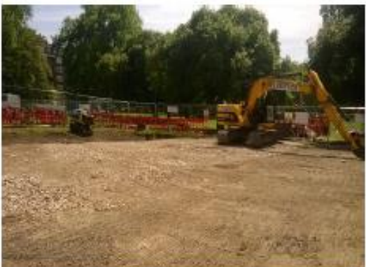
6) Piling Mat Install
